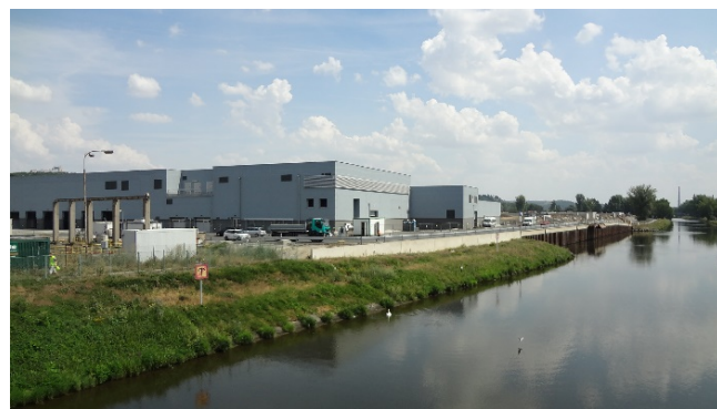
NVL je ojedinělý projekt podzemní zastřešené čistírny. Celou technologii řídí systém Siemens.
